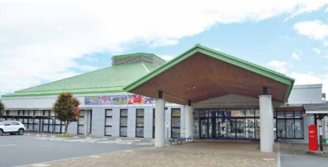
乙亥会館 平成30年7月豪雨で、西予市野村町の乙亥会館は肱川の氾濫により1階部分が完全に水没した。令和2年に復旧工事を完了し、現在は会館内に災害の記録と記憶を継承する「災害伝承展示室」も設けられている。
